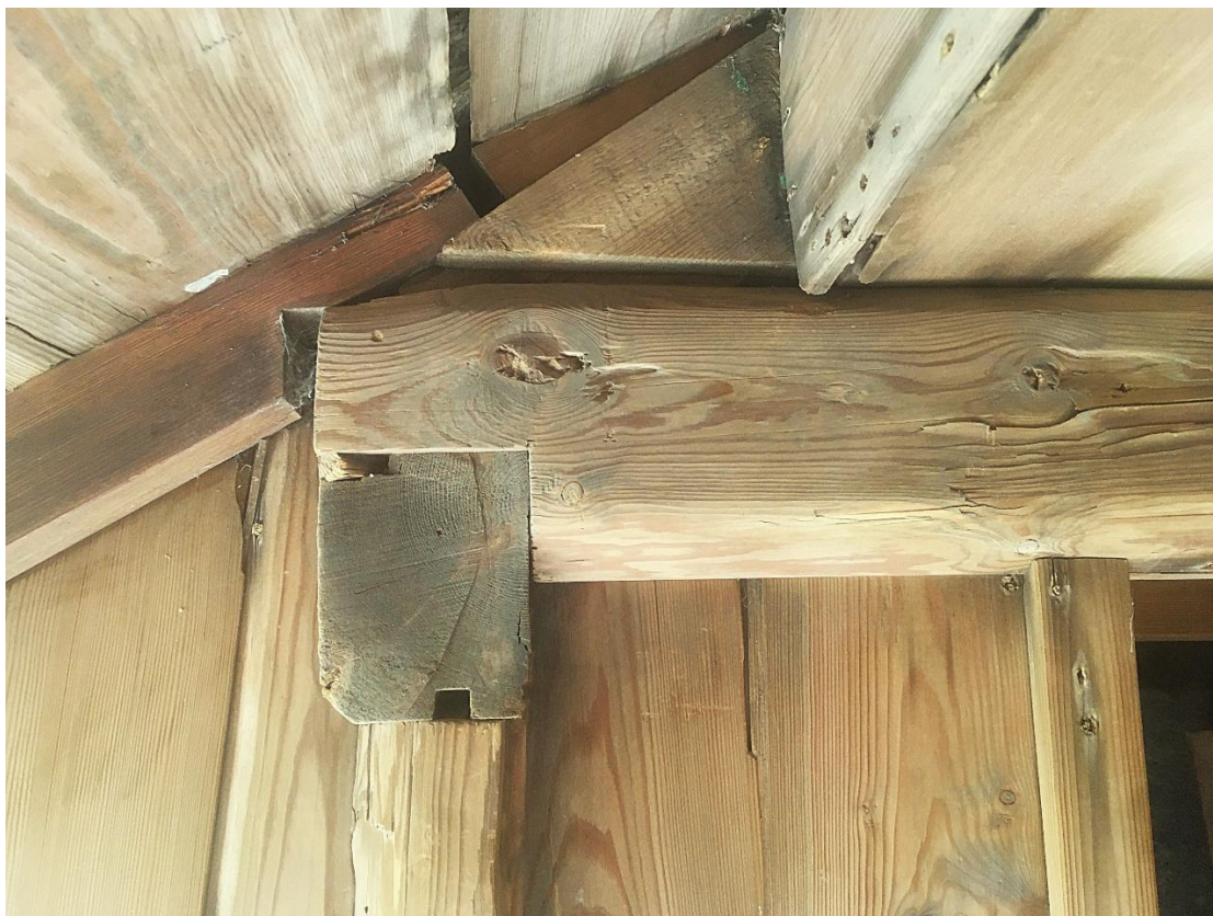
Her ses samlingen mellem rem, bjælke og spær på Færøhuset på Frilandsmuseet i Lyngby. Ved et dørhul, hvor remmen er afbrudt. Læg mærke til den særlige krydskæmning ved bjælke-rem-samlingen. (ses kun svagt her). Udskudsspæret ligger oven på hovedhusets spær.
