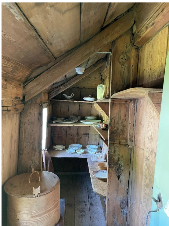
De lave udskud på siderne af færøhuset er en vigtig del af husets energieffektivitet – sammen med de tætbankede stavvægge. På Frilandsmuseets færøhus er der et lille spisekammer i det ene udskud og sovealkover i de andre. Udskuddene repræsenterer, rigtig brugt, en zone med stillestående luft, der isolerer huset meget effektivt.
