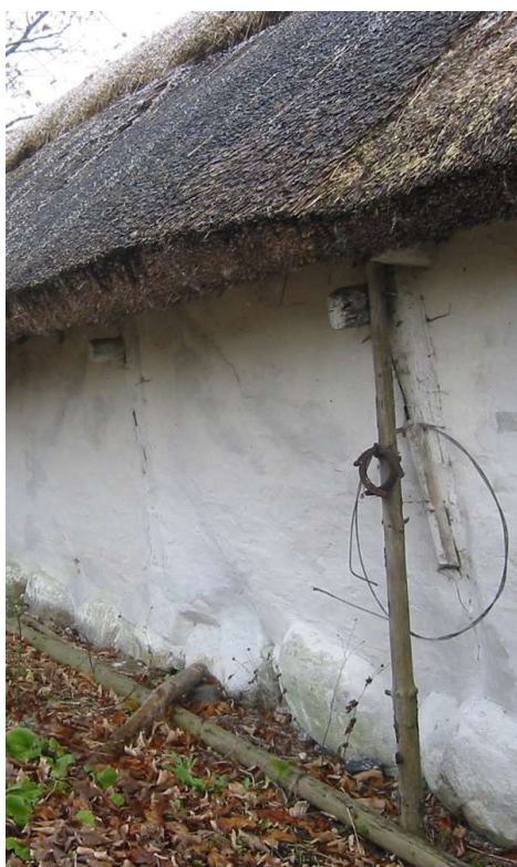
Til venstre det østdanske styrtrumshus med de 'glammede' bjælker, synlige i facaden, under tagskægget. Til højre de fynske gennemstukne tappe, ligeledes synlige under tagskægget
