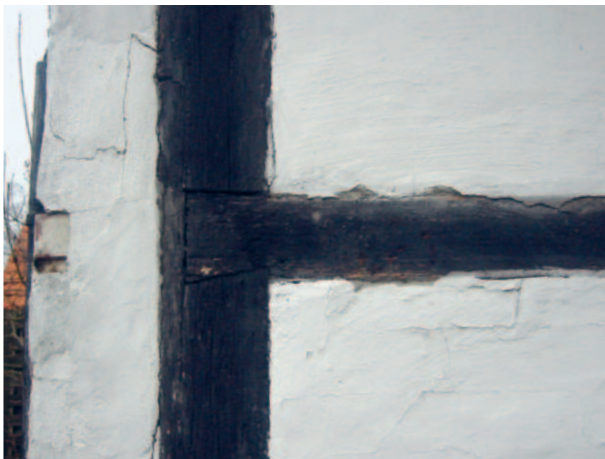
Sørup. Den særlige 'sjællandske' bindingsværkskonstruktion med udvendige vandrette 'sidebånd' rummer en meget speciel detalje, nemlig en 'kæmnet svalehale' eller en 'svalehale-kæmning'. Denne ses her både 'in natura' og i tegning. Se i øvrigt side 42.
