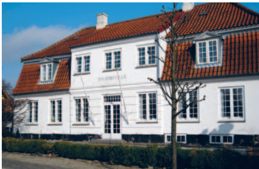
Slotsgade. 'Bournonville', opført 1761 er med sit manzardtag og det fremhævede midterparti typisk for rokokoen. Vinduerne har formentlig oprindeligt været perlegrå og yderdøren uden glas.
