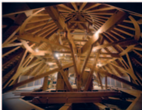
ROSkilde DØMKIRKE - KØRSSKÆRINGENS TAGE Renovering
