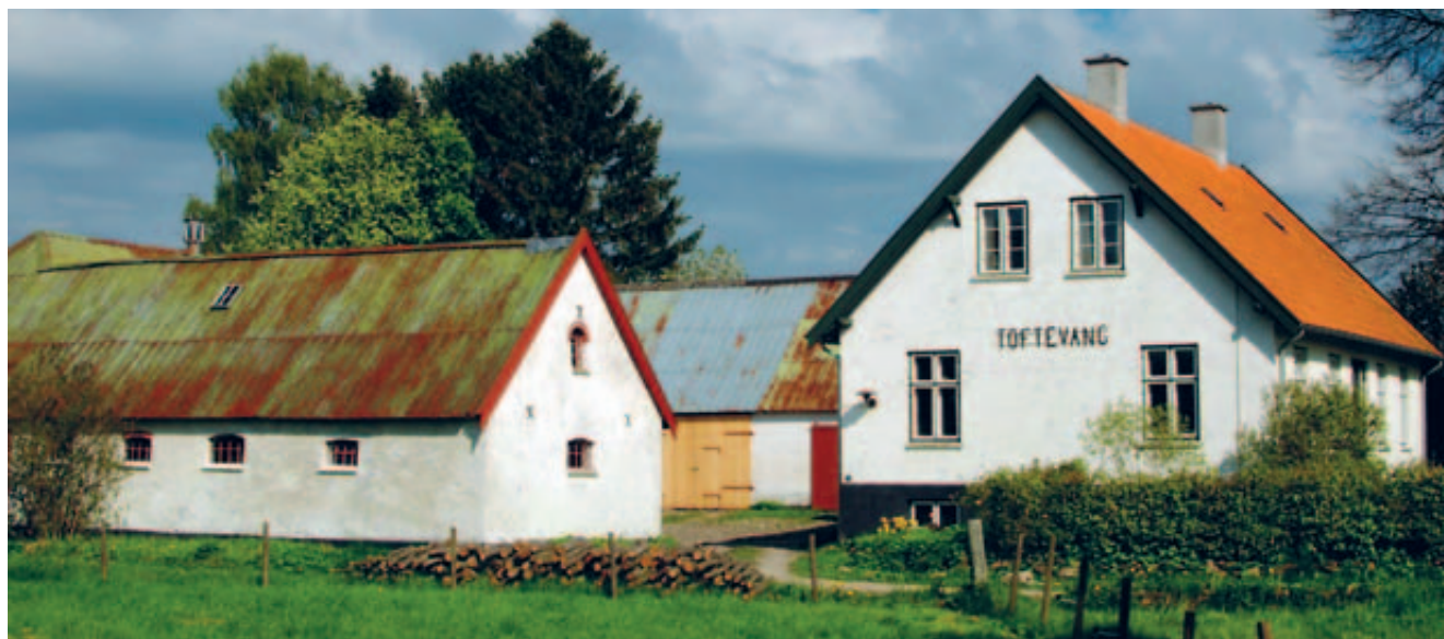
Gården 'Toftevang' i Veksebo er et typisk eksempel på en nybygget gård fra slutningen af 1800-tallet med de for sin tid typiske byggemåder og materialer, bl.a. grundmur, på stuehuset med tegltag og på udlængerne moderne bliktage, der mange steder afløste stråtagene.
