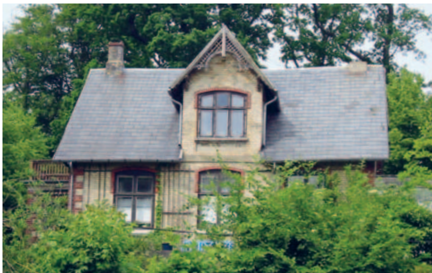
Skifertagene kommer til Danmark i 1850-erne og er med sit store udhæng nærmest synonym med historicismens bygninger. Her 'Kejserens Villa' i Fredensborg, der har tilhørt den russiske Zar Nicolai III i 1885 – der er i rendyrket 'schweizerstil'.
