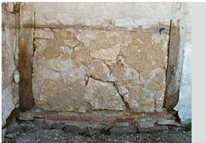
Øverst: Kassemur med vandret skiftegang. Foto: Anne Lindegaard. Nederst: Rå kridtstensblokke passet sammen. Foto: Østsjællands Museum.
