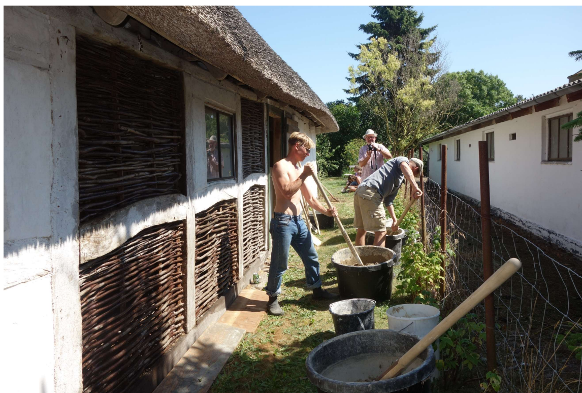
Lerklining af flettede bindingsværkstavl som led i forskningsprojektet i Viby i 2013.
