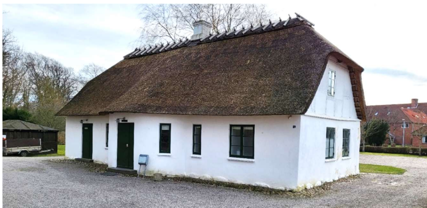
Reventlow Asylet i Horshunde på Lolland. Opført i 1824 i wellerwände – let kendelig på den krumme ydervæg, der ikke kan udføres i pisé, og taggavlen af bindingsværk.
