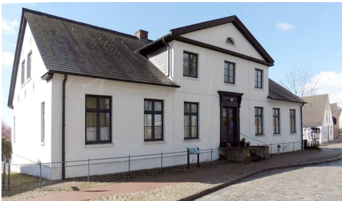
Brandinspektør Boeckmann's hus i Meldorf i Ditmarsken, opført i 1795 af Landbygmester C. F. Hansen. Huset er opført i pisé-teknik (stampet lerjord), der på dette tidspunkt var en helt ny 'fransk' byggeteknik i Nordtyskland, til forskel fra den lokale 'wellerwände-teknik'. Huset er stadig det eneste pisé-hus i landsdelen.
