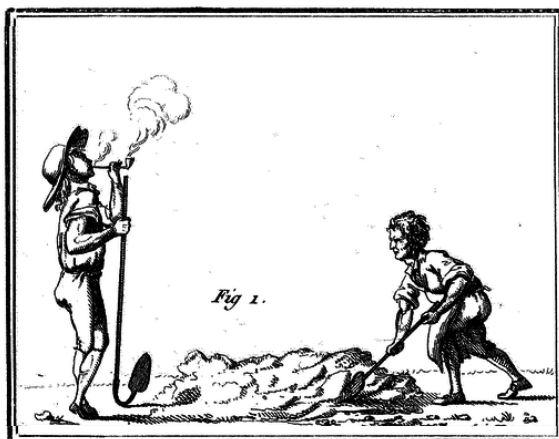
Folkelivsbilleder fra Frankrig under blandingen af lerjordsmassen til pisé-væggene. Kunne også være fra Danmark – måske med lidt mindre skyggende hatte. Efter François Cointereax, 1791.
