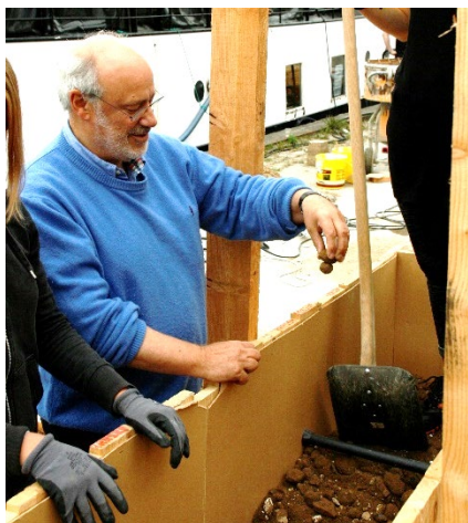
Lerblandingens rette fugtighed afprøves ved 'klæbemetoden' – her fra bygningen af et pisé-hus på KADK i 2013. Til højre en lidt enklere pisé-metode med løse formbrædder sat mod udvendige stolper – fra Cointeraux's bog.
