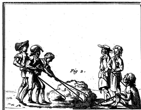
Folkelivsbilleder fra Frankrig under blandingen af lerjordsmassen til pisé-væggene. Kunne også være fra Danmark – måske med lidt mindre skyggende hatte. Efter François Cointereax, 1791.
