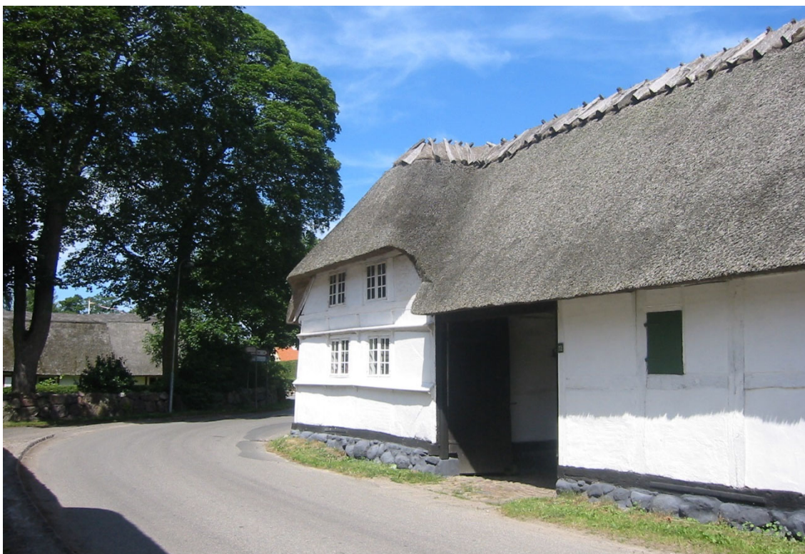
Viby Bygade 12 er kalket hvidt over 'stok og sten', hvilket kræver at bindingsværket først males med limfarve med kridt, for at hvidtekalken kan binde. De skrå vandbrædder på gavlen er malet med hvid kaseinlimfarve. Fodremmen er malet med sort træbjærefarve og stensoklen er kalket med hvidtekalk, iblandet sodsort/kønrøg pigment.
