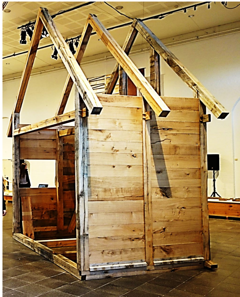
Forsøgshus #1 (2019) Bulhus af nyfældet egetræ med CNC-fræsede samlinger NEXT uddannelse København
