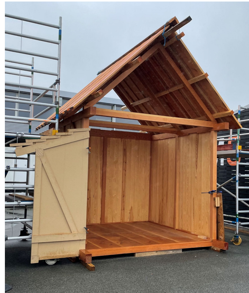
Forsøgshus #3 (2021-2022) Færøsk stavhus med notede vægge Håndfræsede skabelon-samlinger NEXT Kbh. og Frilandsmuseet m.fl.
