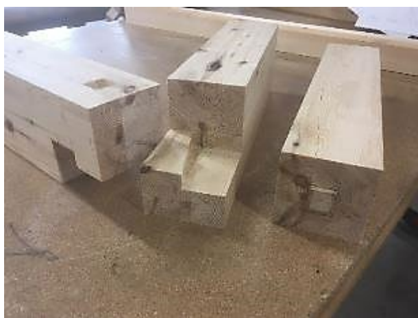
Færøhusets selvlåsende hjørnesamling. Stolpen står dog kun på en ganske lille tap – plus tyngdekraften.
