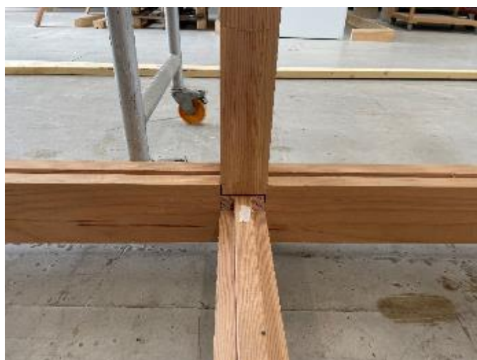
3-punktssamling mellem fodrem, gulvbjælke og vægstolpe. 4-punktssamling ved taghjørne. Alle uden jern.
