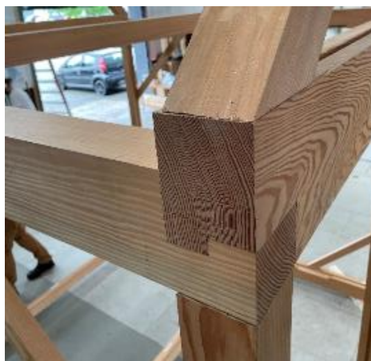
3-punktssamling mellem fodrem, gulvbjælke og vægstolpe. 4-punktssamling ved taghjørne. Alle uden jern.
