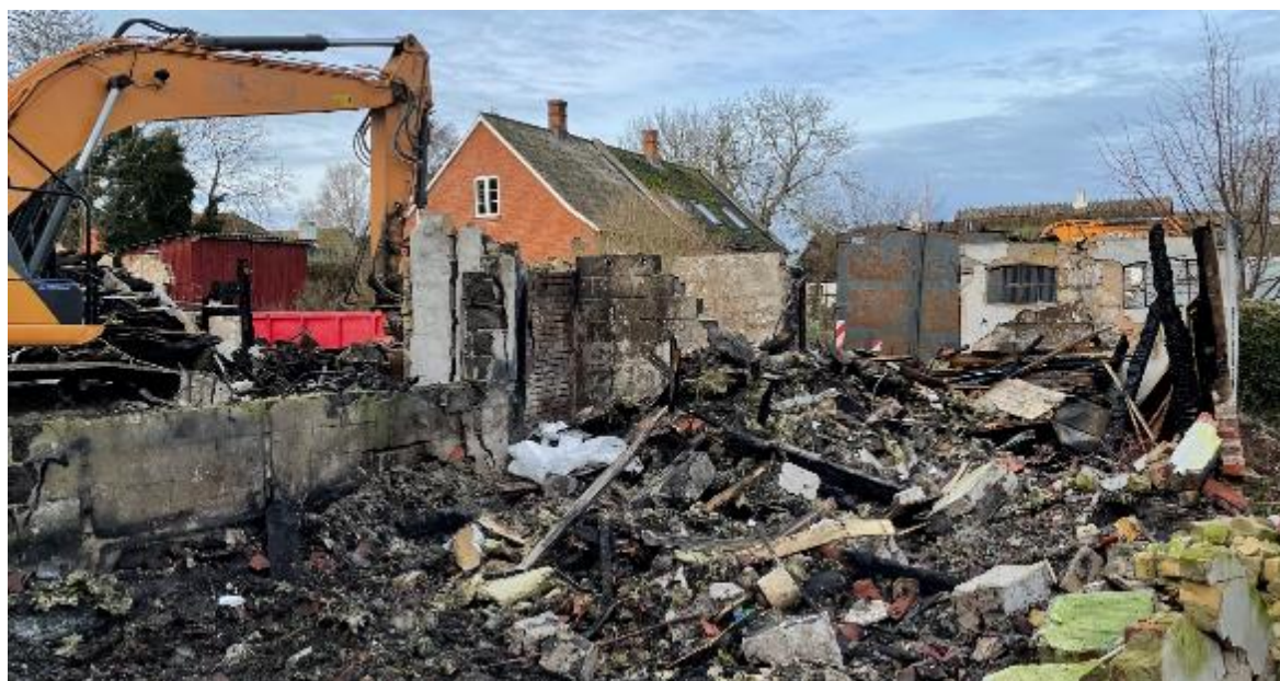
Bindingsværkshus på Nyord, samlet med sømbeslag, der brændte sommeren 2020, braste meget hurtigt sammen på grund af disse.
