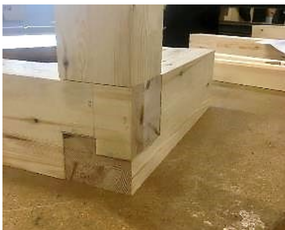
Færøhusets selvlåsende hjørnesamling. Stolpen står dog kun på en ganske lille tap – plus tyngdekraften.
