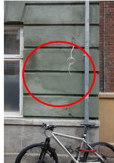
Skjolder efter nyere pudsreparationer, t.v. efter indmurede jern. T.h. alm. pudsreparation
