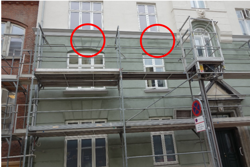
Skjolder efter nyere pudsreparationer, t.v. efter indmurede jern. T.h. alm. pudsreparation
