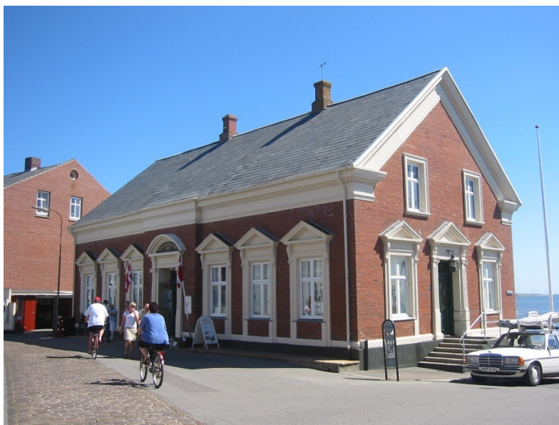
Historicistisk bygning i Esbjerg med støbte facade-dekorationer i portland-cement. Det giver et meget smukt samspil mellem det glatte rødstensmurværk og de fremtrukne dekorationer omkring vinduer og døre – samt gesimser og bånd.
