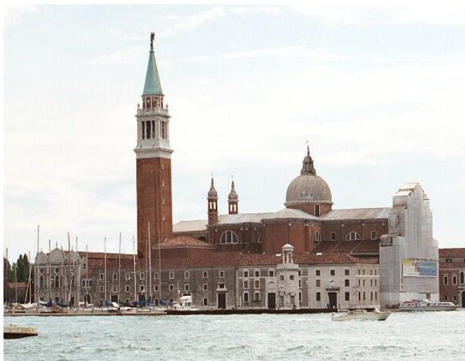
Chiesa San Giorgio Maggiore, Venezia er pudset med kalkpuds, der er gjort hydraulisk med teglmel, hvad der giver pudsens en smuk teglrød farve – se selve blandingen af pudsens side 3
