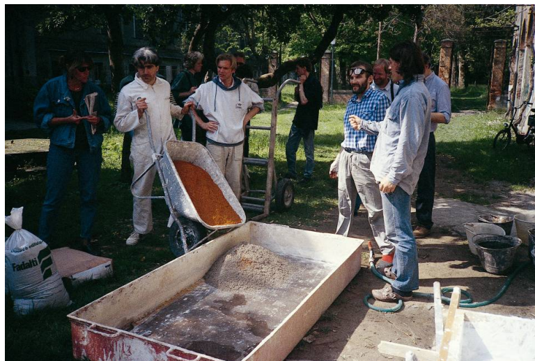
Luftkalkmørtel iblandet teglmel (brændt ler ved 1000 °C) bliver hydraulisk (vandhærdende).
