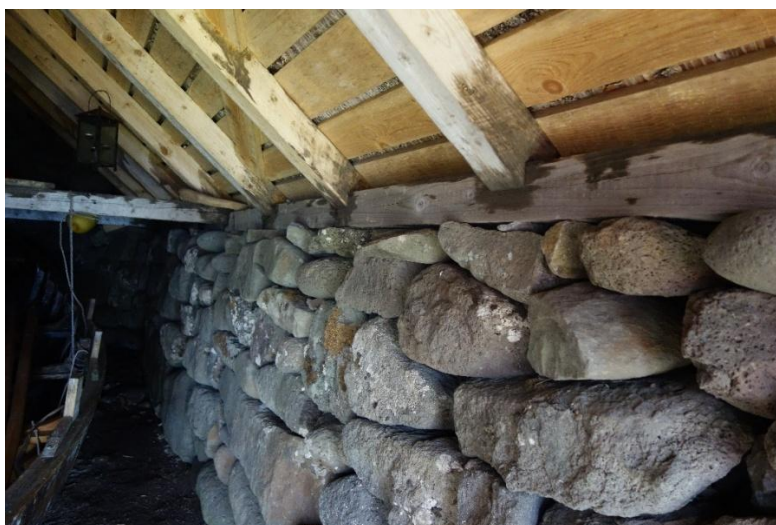
Tørstabelt stenmur i et bådehus (naust). Taget bæres af remme oven på murkronen, hvorpå spærene er fæstnet med såkaldte 'kløer', holdt nede af det tonstunge græstørvstag og derfor kun med tyngdekraften som 'binding'.
