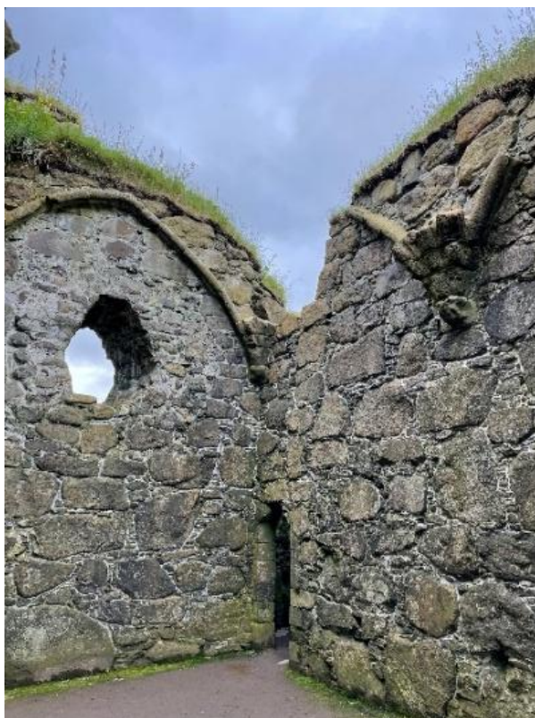
Kyklop-murværk på domkirkeruinen i Kirkjubøur
