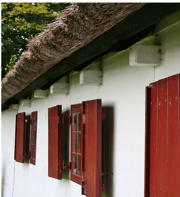
T.v. et østdansk styrtrumshus med 'glammede' bindbjælker på siden af stolperne.
