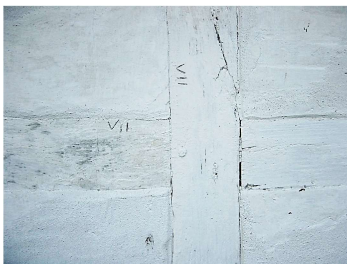
Gennemstukket tap med de to 'låsekiler' og bindingsværk, nummereret med romertallet '7'
