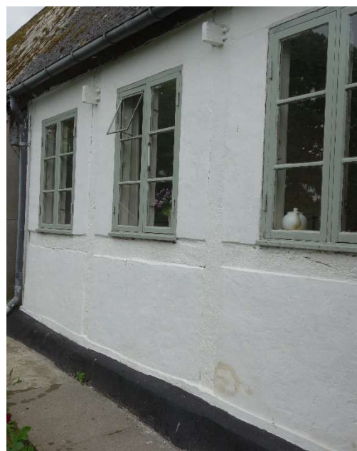
T.v. et østdansk styrtrumshus med 'glammede' bindbjælker på siden af stolperne.
