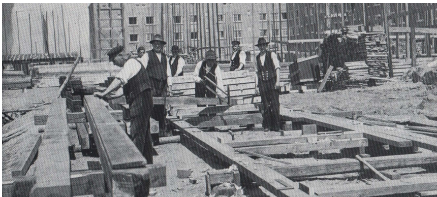
Afbindingsplads på et større tysk byggeri i 1930-erne.
