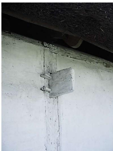
Gennemstukket tap med de to 'låsekiler' og bindingsværk, nummereret med romertallet '7'
