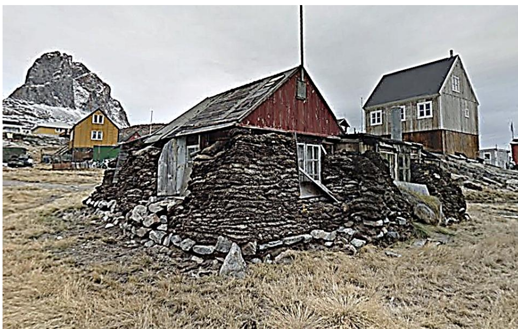
Tørvemurshus Type 4, nyligt fraflyttet, i Umannaq fotograferet i 1981. Her er der kun sten i selve fundamentet og taget går ud over tørvemuren.
