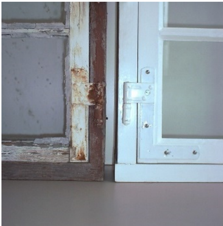
Et uistandsat og et istandsat gammelt vindue af træ. Man kan ligefrem se, hvordan linoliemalingen giver træet og vinduet liv igen.
