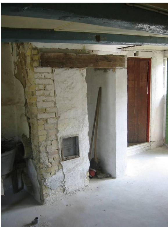
Ildstedet under arbejdet
