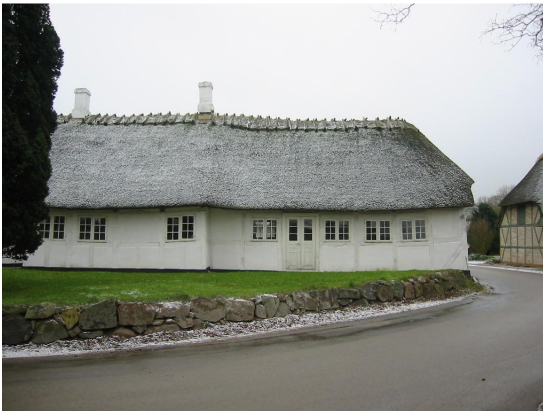
Det flyttede stengærde, før forhøjelsen.
