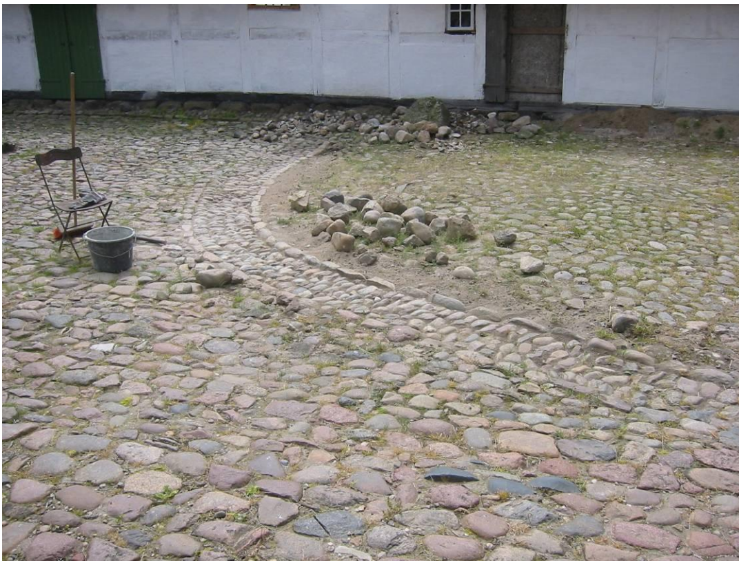
Den krumme afløbsrende fra møddingspladsen er retableret
