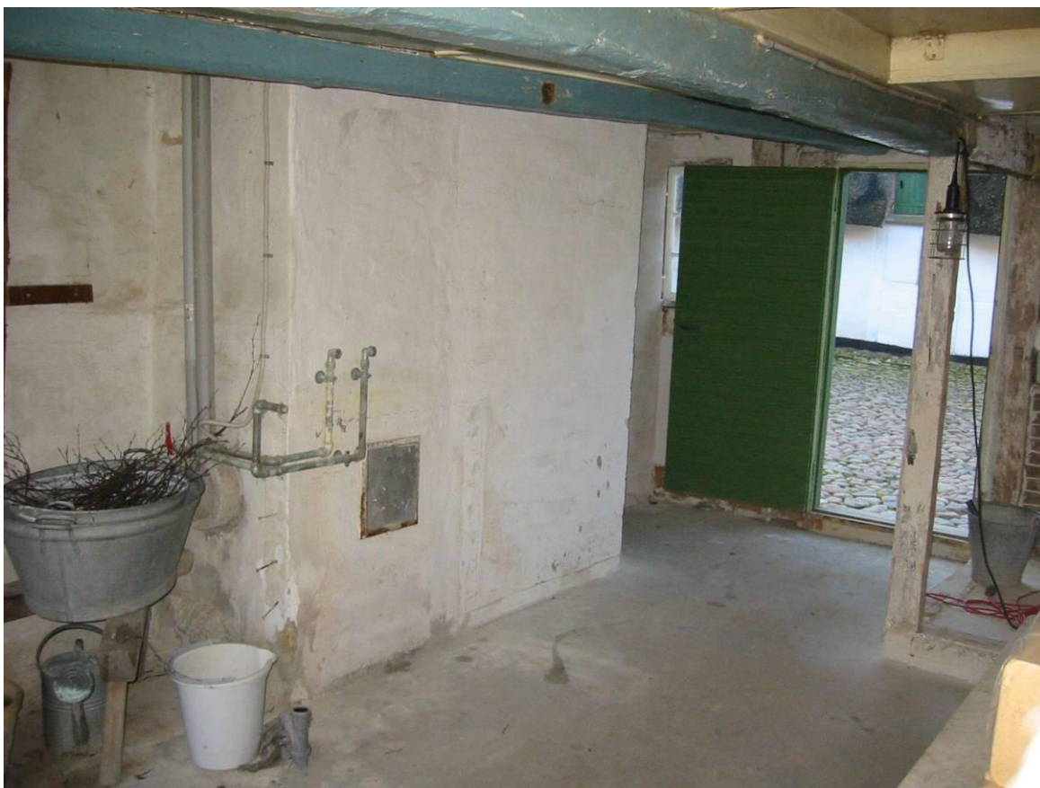
Bryggerset før retableringen af ildstedet.
