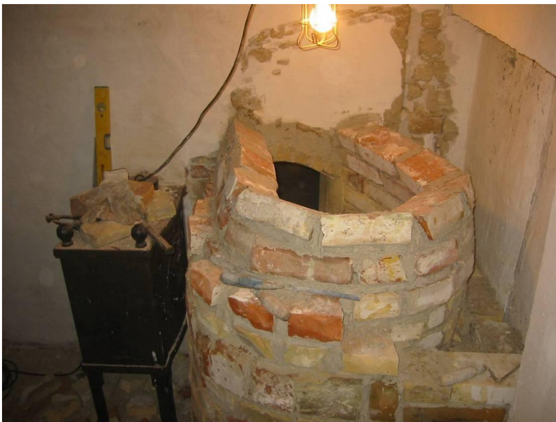
Bageovnen under opbygningen af bageovnskappen
