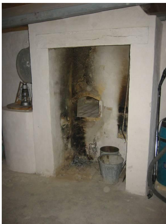
Det færdige ildsted med bageovn og gruekedel
