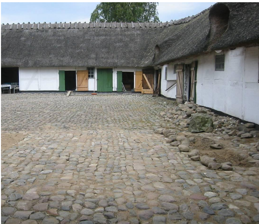
Brolægningen på gårdspladsen er næsten færdig-retableret.
