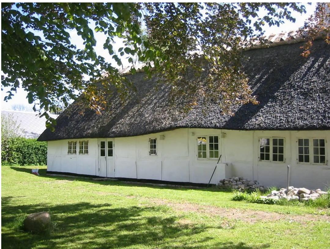
Det nye kursuslokale er på vej til at blive indrettet i stuehusets ene ende. Der er sat to nye vinduer og en dør i.
