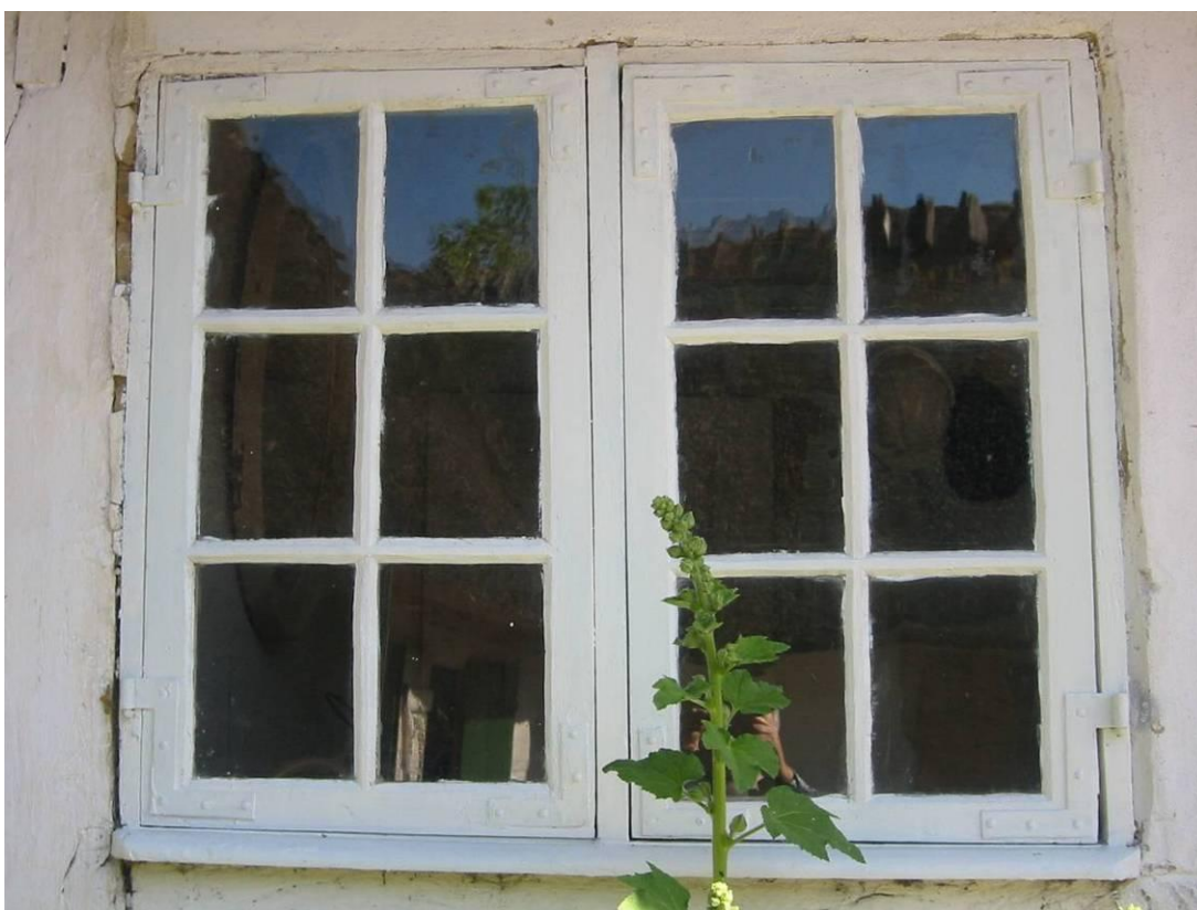
De udvendige beslag er skiftet ud med håndsmedede beslag, magen til de oprindelige.
