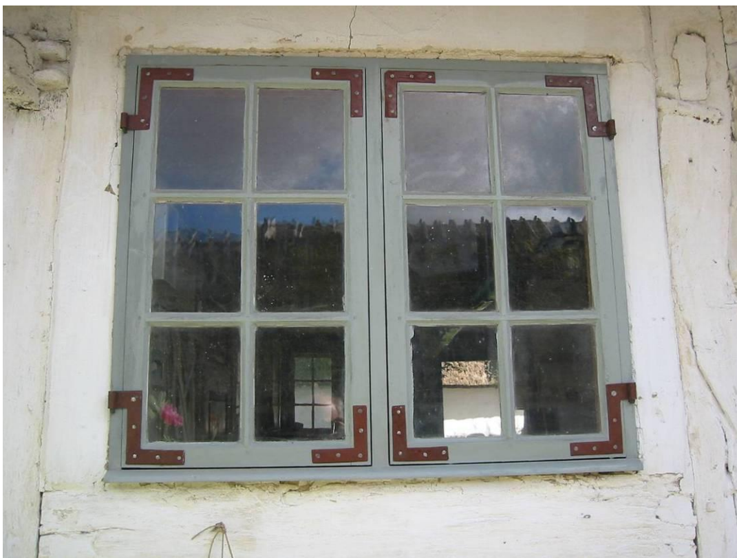
De udvendige beslag er skiftet ud med håndsmedede beslag, magen til de oprindelige.
